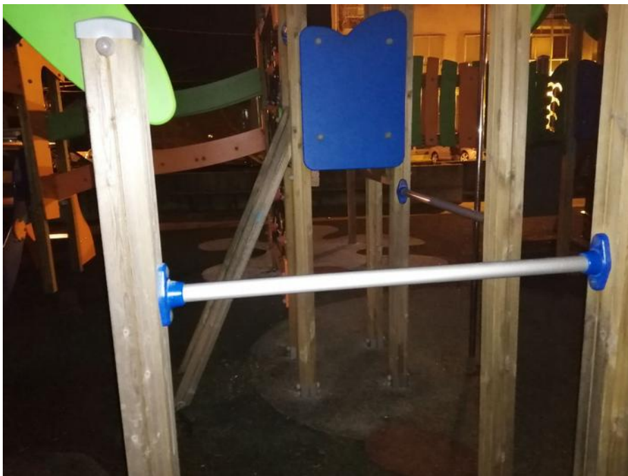
Estruturas metálicas sen recubrir
